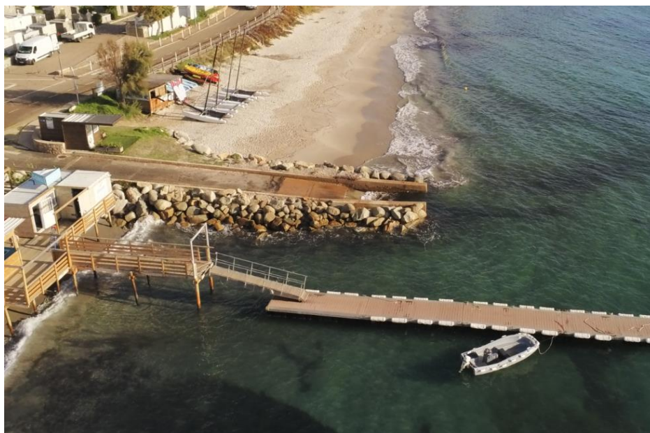
Figure 7 : Cale de mise à l'eau et ponton de débarquement de Pinarello (octobre 2020 - Mairie de Monza)
